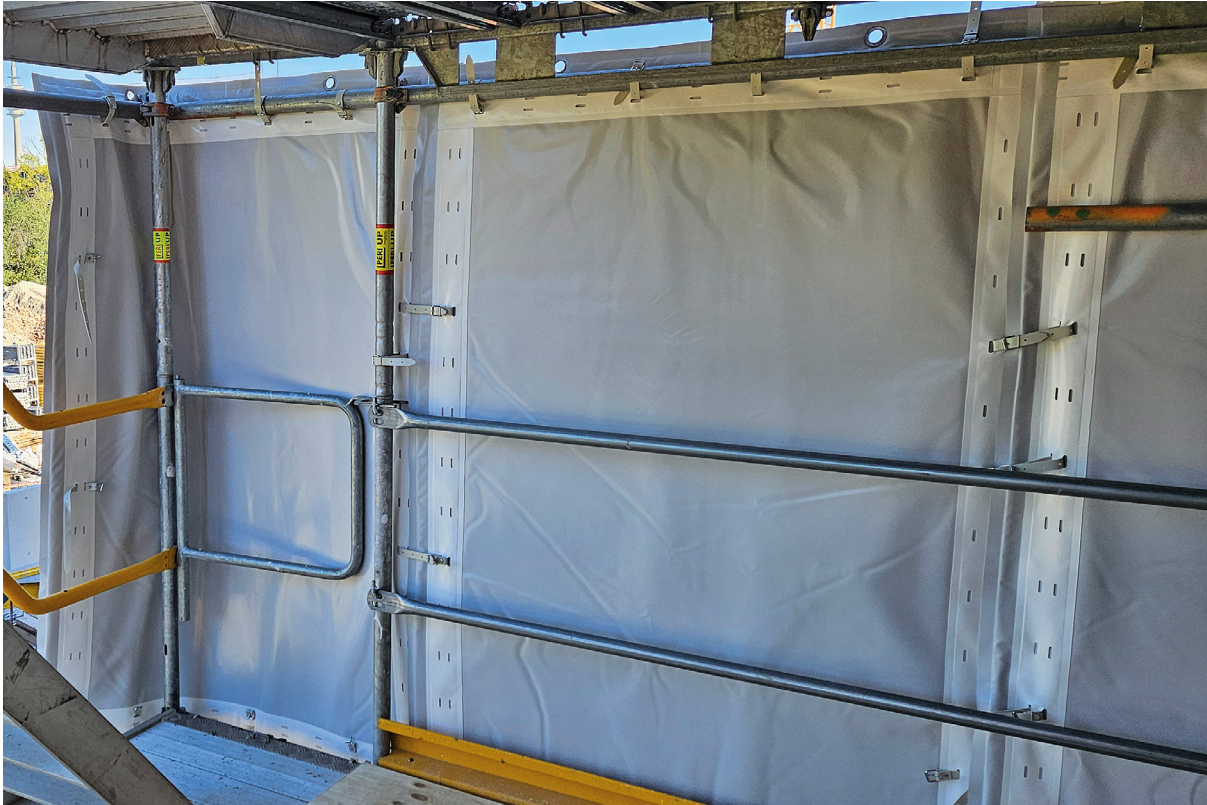
Bild 4: Befestigung am Gerüststiel, Verbindung von Cisilent in Feldmitte
