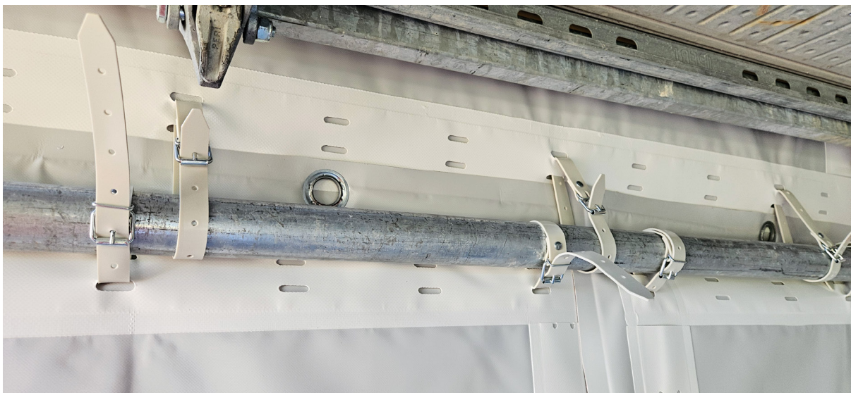
Bild 3: Befestigung am Gerüstriegel, obere Überlappung
