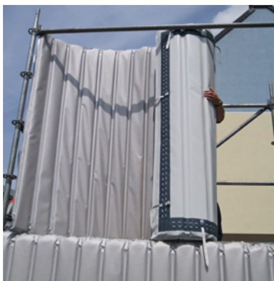
Ausrollen im Gerüstfeld
