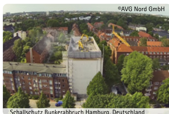
Schallschutz Bunkerabbruch Hamburg, Deutschland
