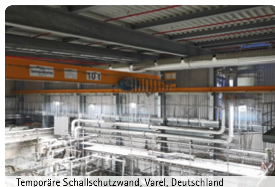
Temporäre Schallschutzwand, Varel, Deutschland
