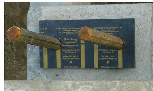
Fläche eben, Betonausbruch an Ecke
