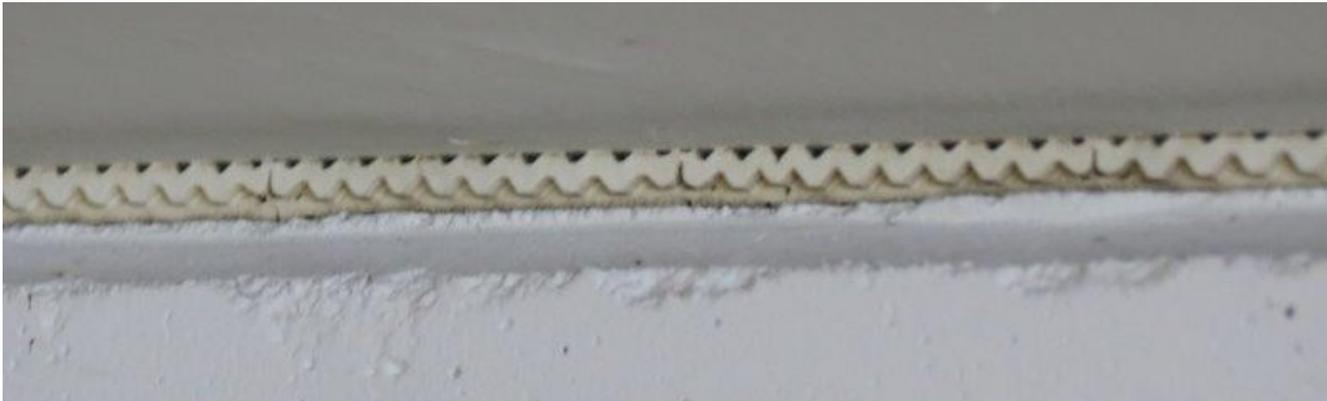
so nicht: Höhenausgleich durch Mörtel, Lagerkörper eingemörtelt
