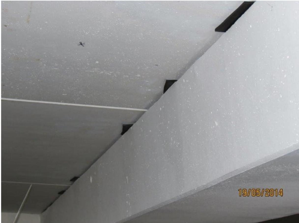
auch keine Lösung: Verformungslager statt Gleitlager
