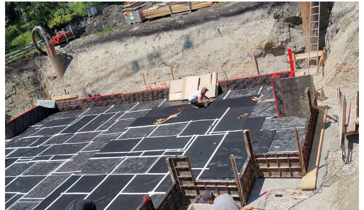
Doppelhaus in Gröbenzell, wegen Grundwasser wird Cimax® unter den tragenden Wänden verlegt
