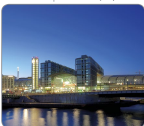
Berliner Hauptbahnhof (DE)
