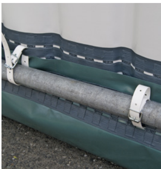
Bild 8: Befestigung Schleppstreifen an Gerüststange
