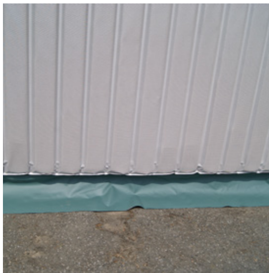
Bild 9: Schleppstreifen zur Lärmquelle ausziehen
