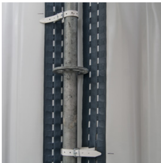
Bild 5: Ausrichtung, Befestigung am Gerüstpfosten
