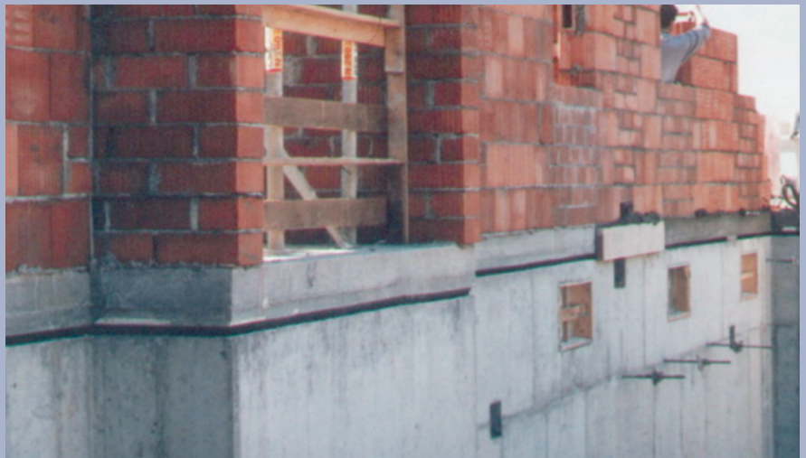
Bild 2: Ausgeschaltete fertige Lagerfuge
