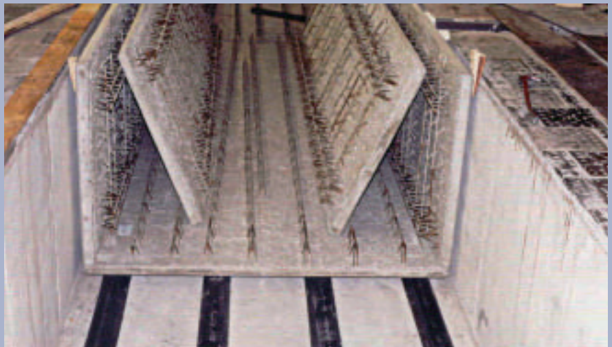
Bild 2: Seitliche Fixierung der Filigranplatten im Einbauzustand
