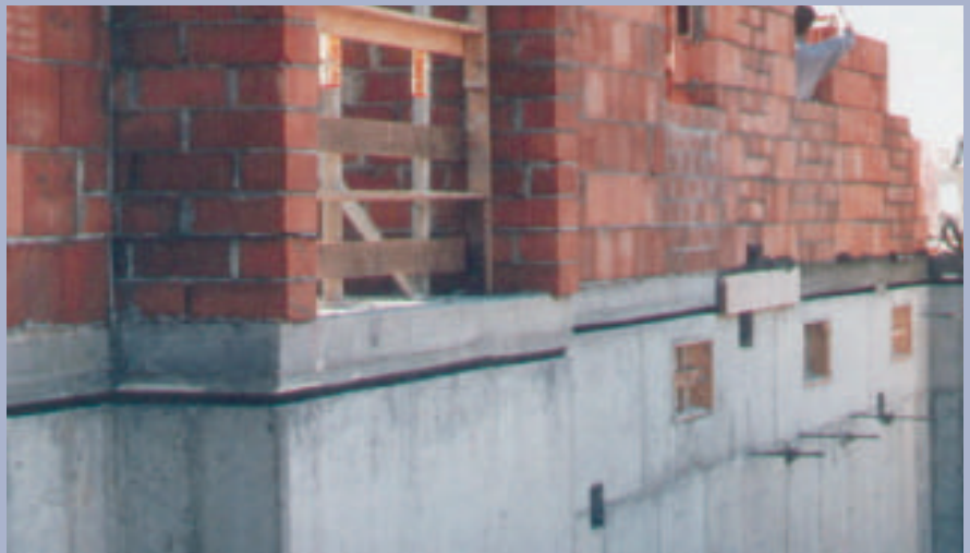
Bild 2: Ausgeschaltete fertige Lagerfuge
