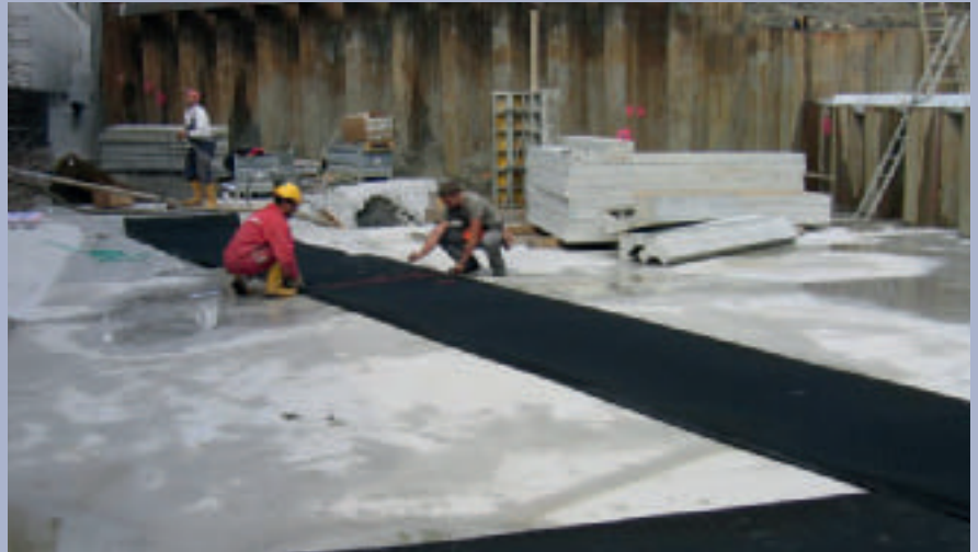
Bild 1: Zuschneiden der Matte
