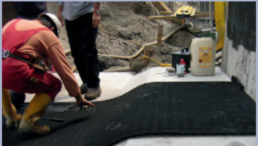
Bild 2: Verlegen der Matte
