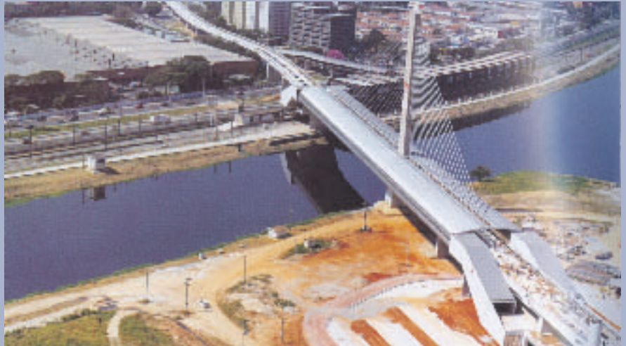
Bild 10: Seilbrücke über den Rio Pinheiros in Sao Paulo (Brasilien)
