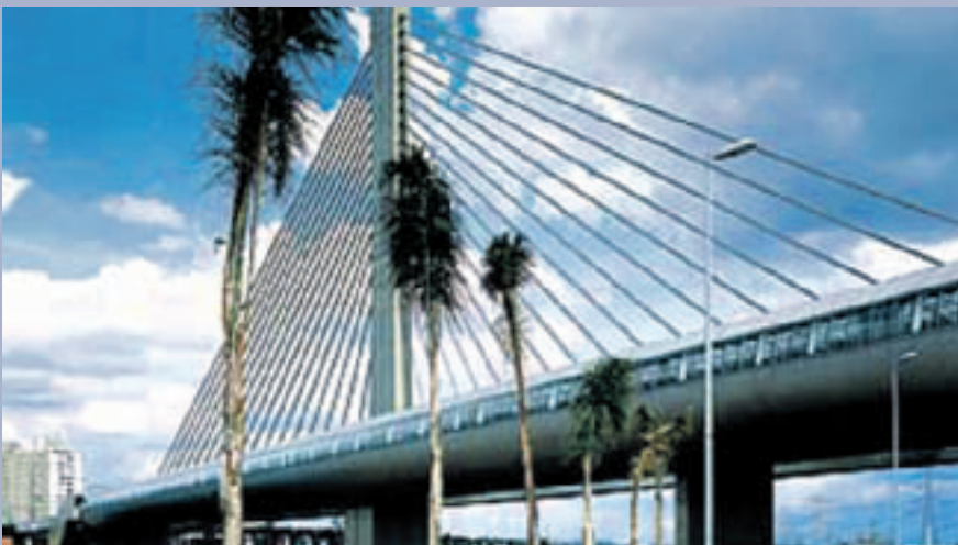
Bild 9: Aufgeständerter Fahrweg mit eingebauten USM® Gleisbettmatten
