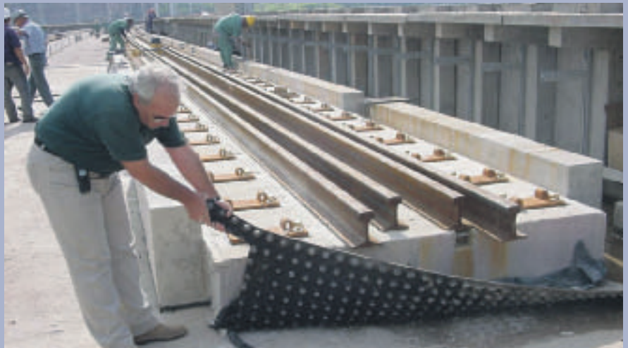
Bild 11: Ausgeschaltetes „leichtes“ Masse-Feder-System mit USM® Gleisbettmatten
